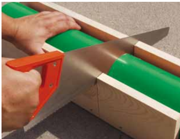
Abbildung 3 Ablängen mit Schneidlade
