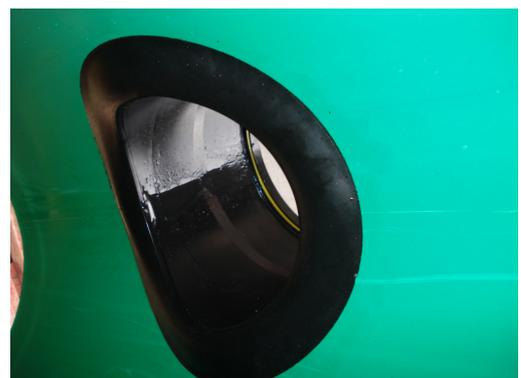
7. Bei ordnungsgemässer Montage liegt die Dichtungslippe sauber und gleichmässig an der Rohrinne wand.
