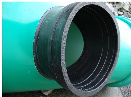
3. Das Gummitteil am Pfeil einknicken und durch die Öffnung einführen bis sich die Dichtungslippe innen im Kanalrohr ausdehnen kann. Nun das Gummitteil umlaufend an die Kunststoffrohrinnenwand drücken und wieder soweit nach oben ziehen, dass die Gummikante an der Oberkante des Kunststoffteils liegt.
