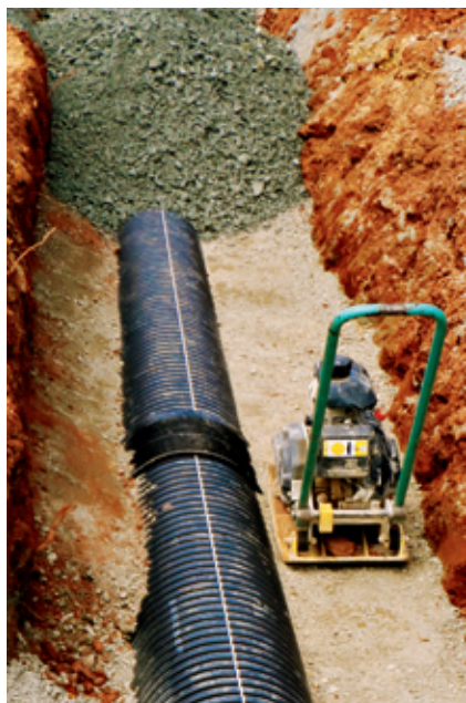
SIROPLAST-K-Mehrzweckrohr zur kombinierten Ableitung von Drän- und Oberflächenwasser
